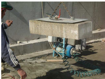
CASO 2 - PONTE DE VILA FRIA
