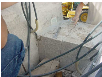
CASO 2 - PONTE DE VILA FRIA
