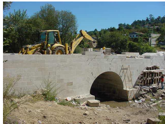
CASO 2 - PONTE DE VILA FRIA
