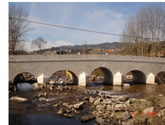
CASO 2 - PONTE DE VILA FRIA
