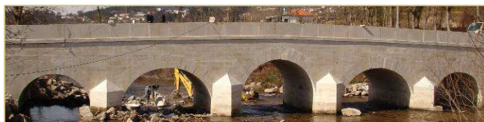
Figura 13: Vista Geral da Ponte.
